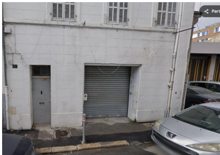
Accès du local au 15 rue du Marché
